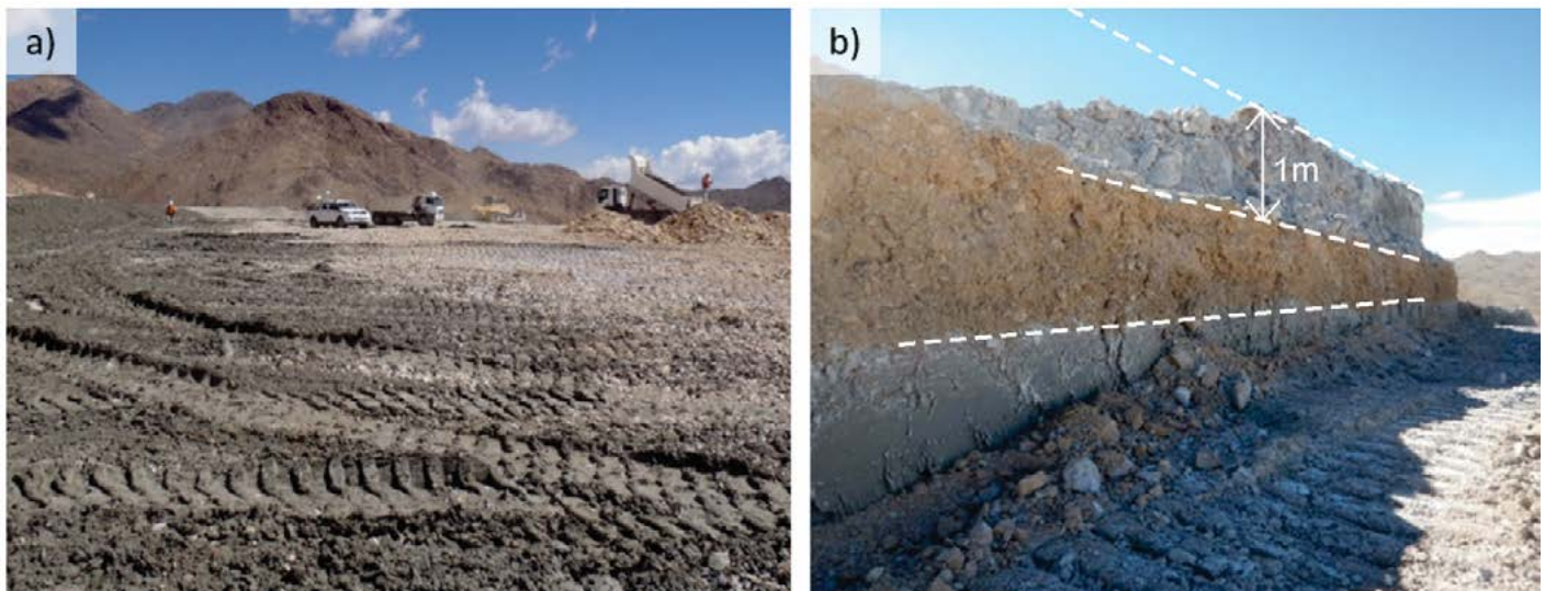
Figura 4. a) Vertido de una nueva capa de colas sobre capa de estéril y b) alternancia de capas de colas y de estéril de aproximadamente 1 m de espesor expuesta en una excavación temporal.
