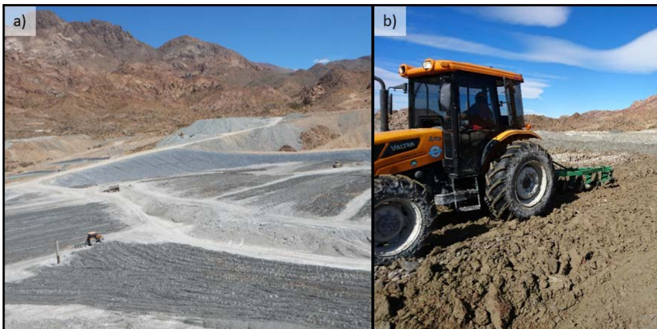
Figura 7. Deposición de colas por volcado, extensión y arado: a) celdas y b) maquinaria de arado.
