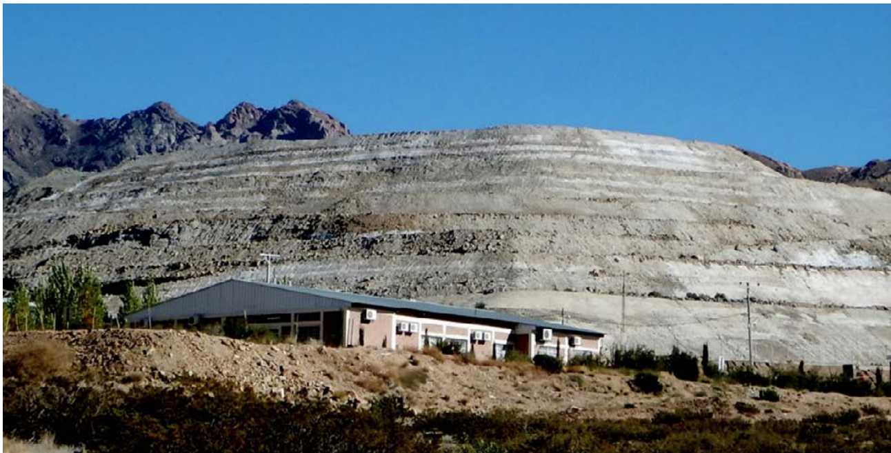
Figura 15. Bandeado claramente visible en los taludes, resultado de la precipitación de sales (eflorescencias) en los bordes de las capas de colas por evaporación del agua que prueba que existe flujo lateral de agua en las capas de colas debido al gradiente de potencial de agua creado por la atmósfera.
