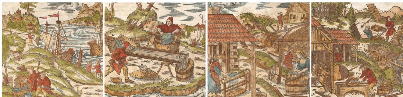
**Figura 11.** Xilografías extraídas de una copia de *De Re metallica* mostrando procesos de tostado, molienda, lavado y fundición de menas (Hoover & Hoover, 1950).
