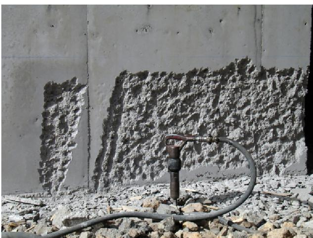
**Figura 1.** Proceso de picado con martillo neumático en muro de hormigón. Interior de la Iglesia del Santísimo Redentor en La Laguna, Tenerife. MENIS Arquitectos.
