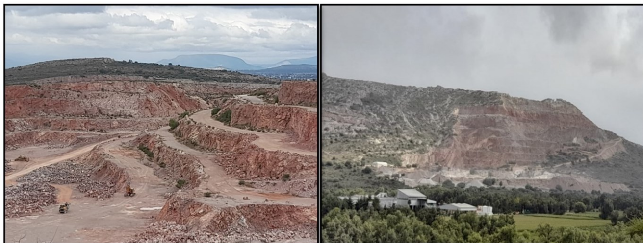
Figura 1. Cambios morfológicos generados por la actividad minera. Foto de la izquierda representa un socavón de aproximadamente 30m de profundidad en la cantera Caleras Beltrán, y foto de la derecha, cortes verticales aplicados al cerro Blanco (Municipio de Atotonilco, Hidalgo). Fuente: Foto tomada en campo el 25 de noviembre de 2023.
