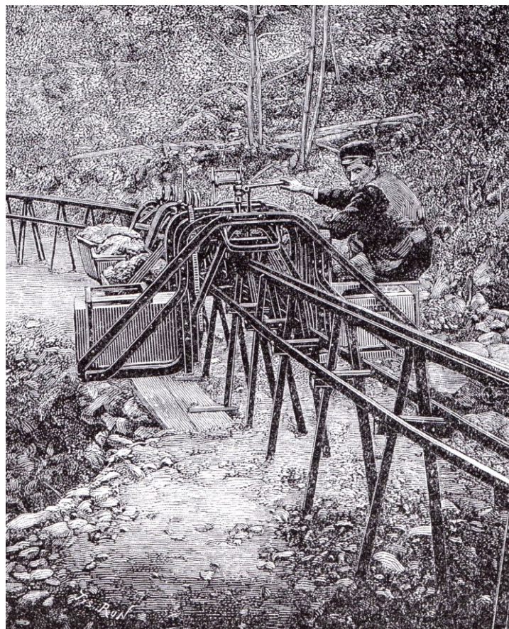
Figura 6. Monorraíl de las minas de Ría (modificada de Behr & Petit, 1886).
