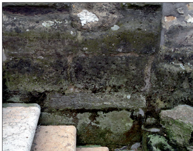
Figura 12. Pátina biogénica sobre la arenisca de La Grandiella Figure 12. Biogenic patina on the La Grandiella sandstone
