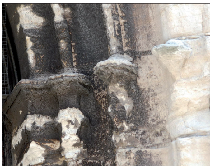
Figura 13. Costra negra y pulverización en la dolomía de Laspra Figure 13. Black crust and granular disintegration into powder in the Laspra dolomite
