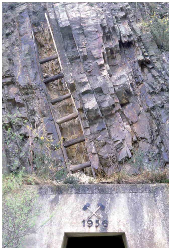
Figura 13. Bocamina de antigua explotación de caolín en Peñaflores (Grado), por encima de la cual se aprecia la capa caolinitizada (fotografía cortesía de Carlos Aramburu).
