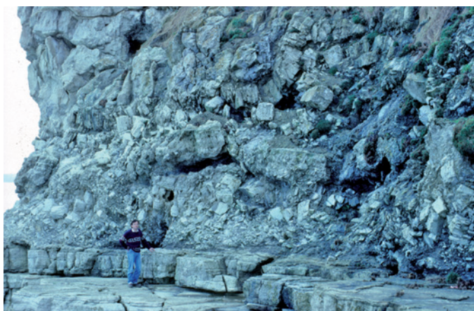
Figura 11. Brecha de colapso formada por bloques calcáreos, originada por disolución de niveles evaporíticos interestratificados dentro de la Formación Gijón, en los acantilados del Cerro de Santa Catalina (Gijón).
