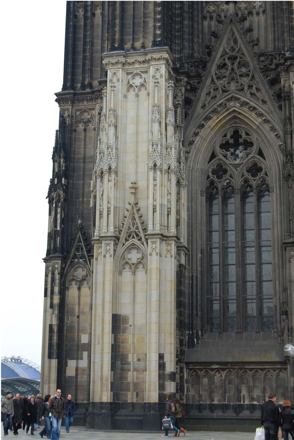
Figure 3. White Obernkirchen sandstone as a replacement stone at the Cologne Cathedral (photo Angela Ehling). Figura 3. Arenisca blanca de Obernkirchen como piedra de reemplazo en la Catedral de Colonia (foto de Angela Ehling).
